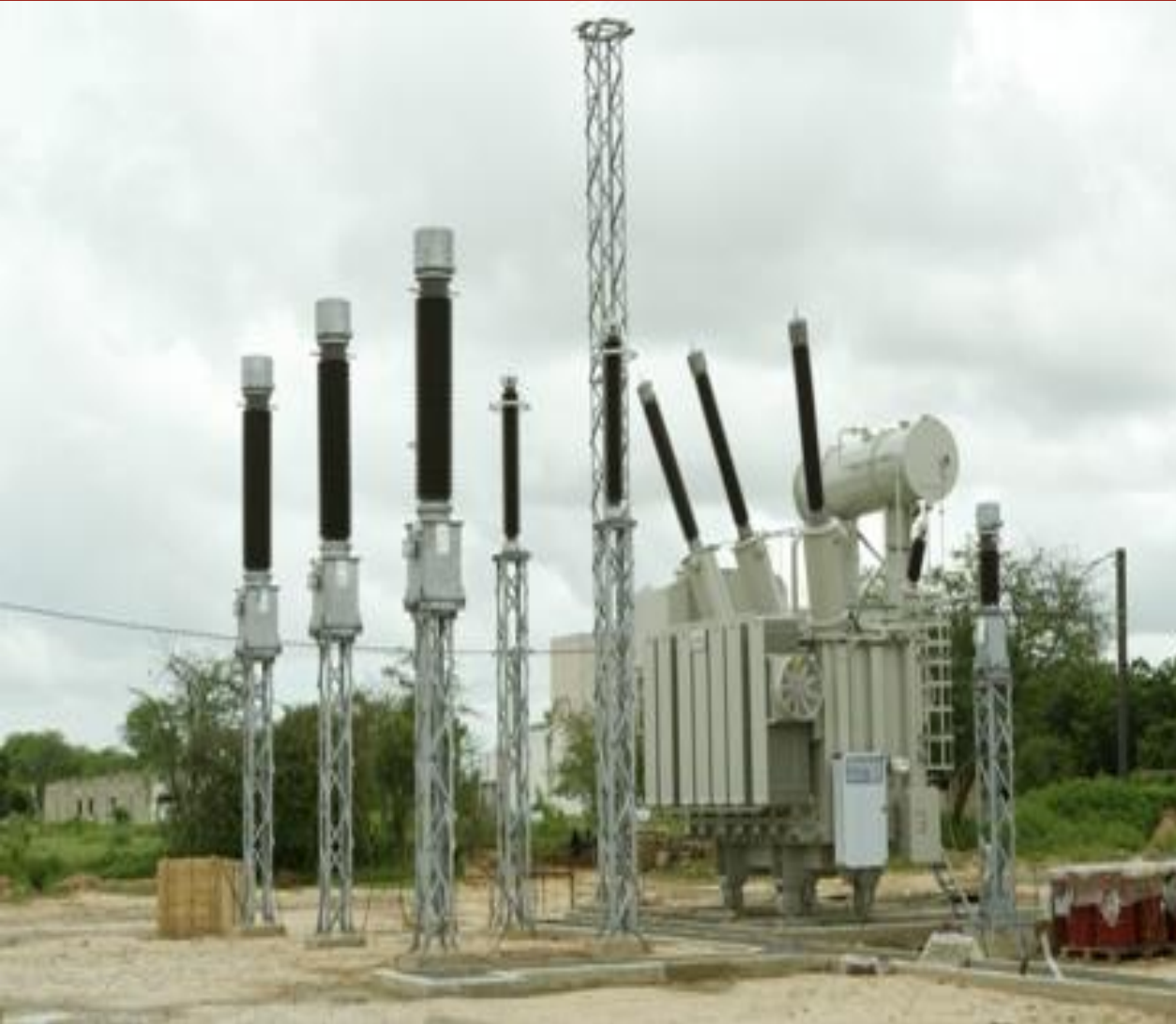
پست های ۲۲۰ کیلوولت اتیوپی
